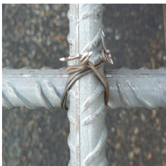
Bild 3.31 „Kreuzschlag“ horizontal liegender Stäbe
