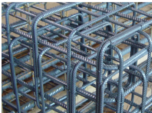
Bild 3.29 Geflechte mit Stabkreuzungen, die aus der Notwendigkeit heraus sowohl mit als auch ohne Maschenknüpfung sind
