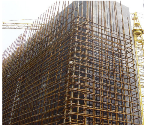
Bild 7.2 Eckenbewehrung einer Wand
