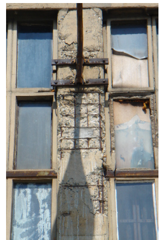
Bild 1.1 Eine Stahlbetonskeletthalles, gebaut 1930, die innen einen Brückenkran hält, gezeichnet von den Umweltbelastungen.
