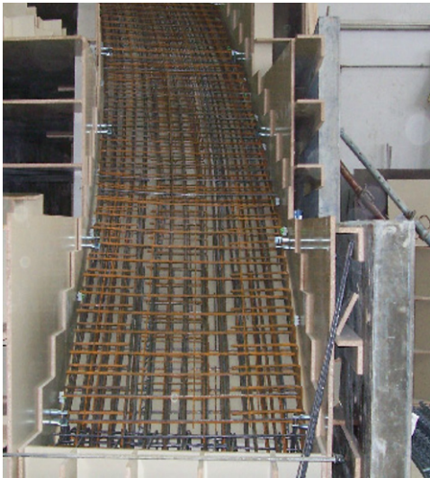
Bild 7.16 Ein einfacher Treppenkorb (links) und ein Treppenkorb mit Stufenausbildung (rechts)
