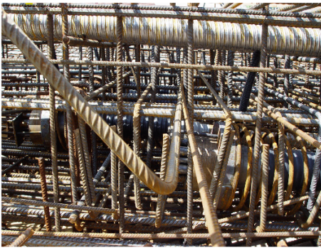
Bild 7.61.1 Aufbau einer Brückenüberbauplatte mit Spannstahlgliedern
