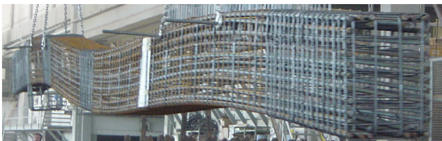
Bild 7.41 Krantransport eines 22 m-langen Stützenkorbes zur Schalung
