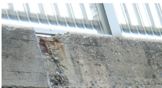
Bild 8.5 Betonabplatzungen durch physische und chemische Umwelteinflüsse mit freiliegendem Stahl
