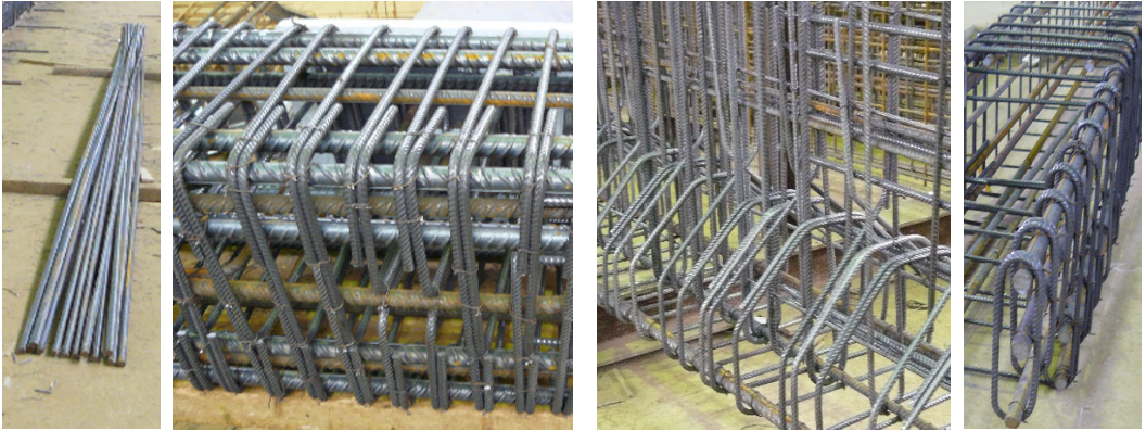
Bild 1.18 Aus mehreren geraden Stäben links werden gebogene Stäbe hergestellt und zu Geflechtem zusammengesetzt
