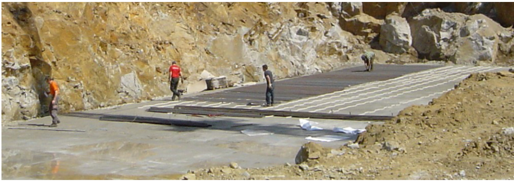
Bild 7.62 Das Auslegen der unteren Lage auf relativ vielen Flächenbetonabstandshaltern (grau)
