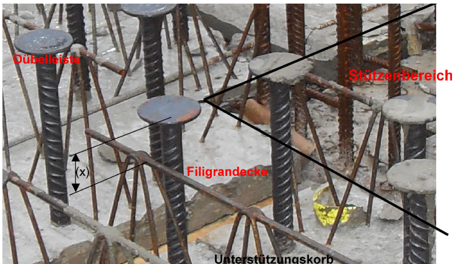
Bild 10.8 Dübel in einer Filigrandecke, die um die Stütze einbetoniert sind und die noch aufzulegende Zulagen (Differenz (x) zwischen den Dübelköpfen und den Unterstützungskörben) auf der Filigrandecke erahnen lässt.
