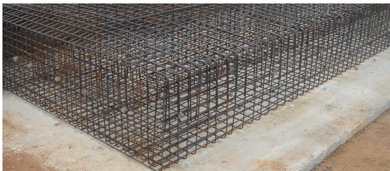
Bild 7.66 Ein fertiger Fundamentkorb mit dem Stab-Knochen-Prinzip gefertigt
