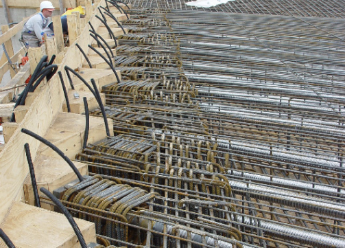
Bild 1.8 Spannstahl in Schutzrohren in der Bewehrung
