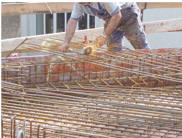
Bild 3.18 Das Flexen auf der Baustelle bei Stabdurchmesser > 12mm
