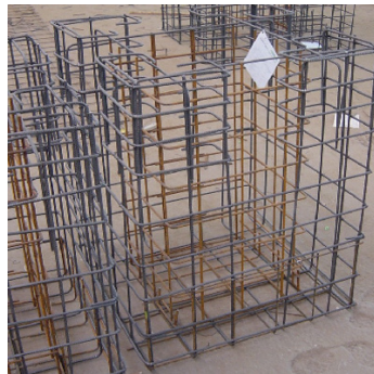
Bild 1.6 Punktfundamenteinlage
