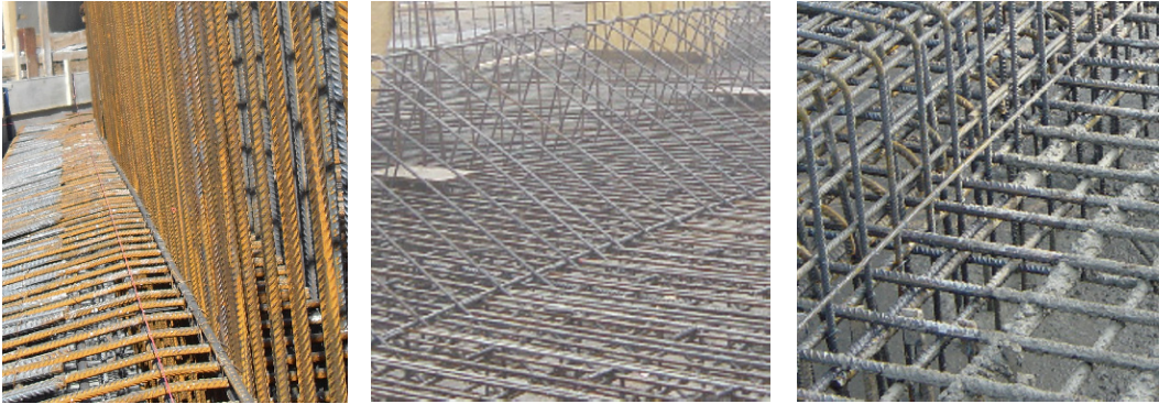
Bild 7.35 „Plattensprung“ in den Varianten schräg und rechtwinklig mit der „Kehlposition“
