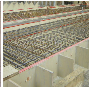
Bild 1.7 Balkonstahleinlage
