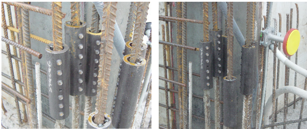
Bild 9.13 Steckmuffe im Einsatz nach dem Abscheren der Schrauben zur Verlängerung einer kurzen Bewehrung
