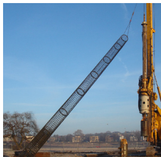
Bild 1.11 Die Bohrpfehleinlage beim Abladen nach dem Antransport, beim Aufnehmen und beim Einfahren ins Bohrrohr
