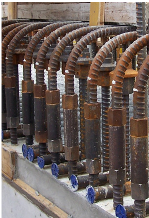
Bild 9.10 Darstellung des Gewindestahles im Einsatz
