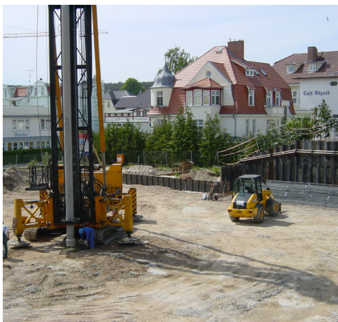
Bild 7.54 Vorbereiten des Bohrrohres
