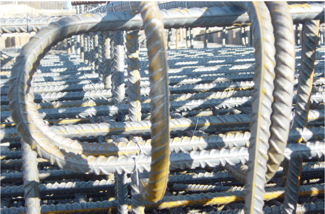
Bild 8.10 Innere Stahlabst nde („die Stabst rke mindestens als eine Betonumh llung“) f r die Betondeckung
