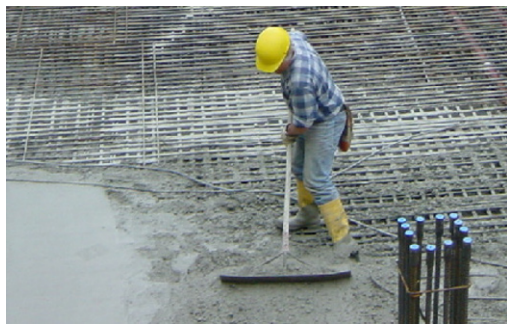
Bild 8.7 Belastung einer Bewehrung noch vor der Fertigstellung und unmittelbar während des Betonierens
