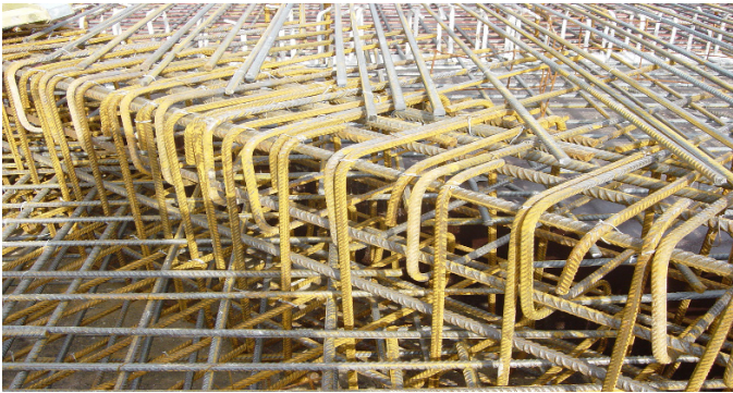
Bild 6.16 Gebogene Matten und Stäbe in einem Deckensprung
