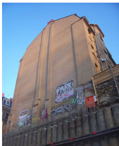
Bild 7.47 Wirkung einer Bohrpfahlwand zur Abfangung eines Gebäudes und einer Baugrube
