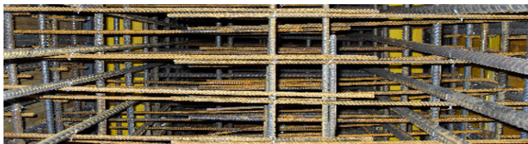
Bild 9.2 Bewehrungsstoß in einem Mehrebenengeflecht (dem Brückenfundament)
