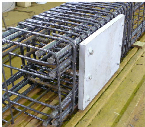
Bild 7.4 Bewehrungskorb einer Stütze
