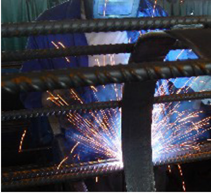
Bild 3.27 MAG-Schweißen am Pfahlkorb
