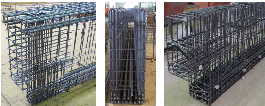
Bild 7.42 Vorgefertigte Balkenkörbe (Unterzüge) mit Auflager links und rechts, mittig ohne Auflage
