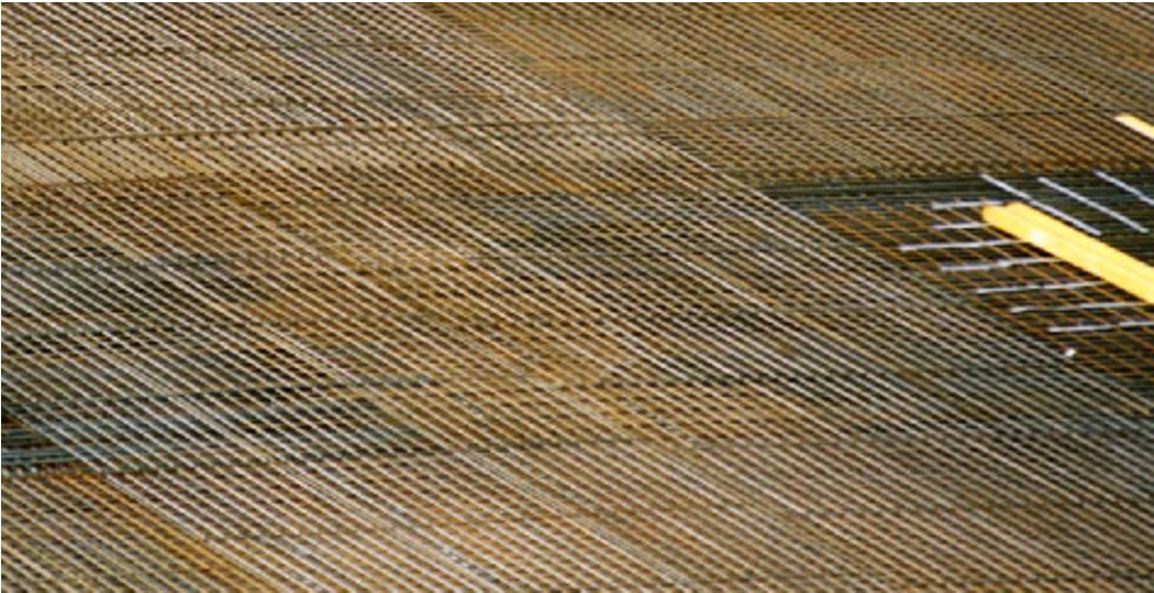
Bild 6.11 Auslegen der Einachslistenmatten auf einer Decke mit der gut erkennbaren Ebenheit der Mattenlage
