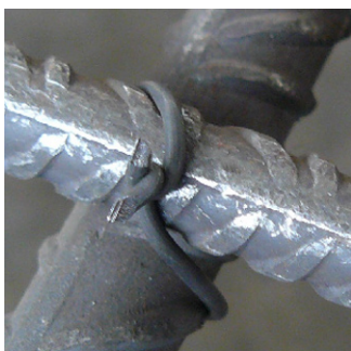
Bild 3.30 „Einfachschlag“ bei horizontal liegenden Stäben
