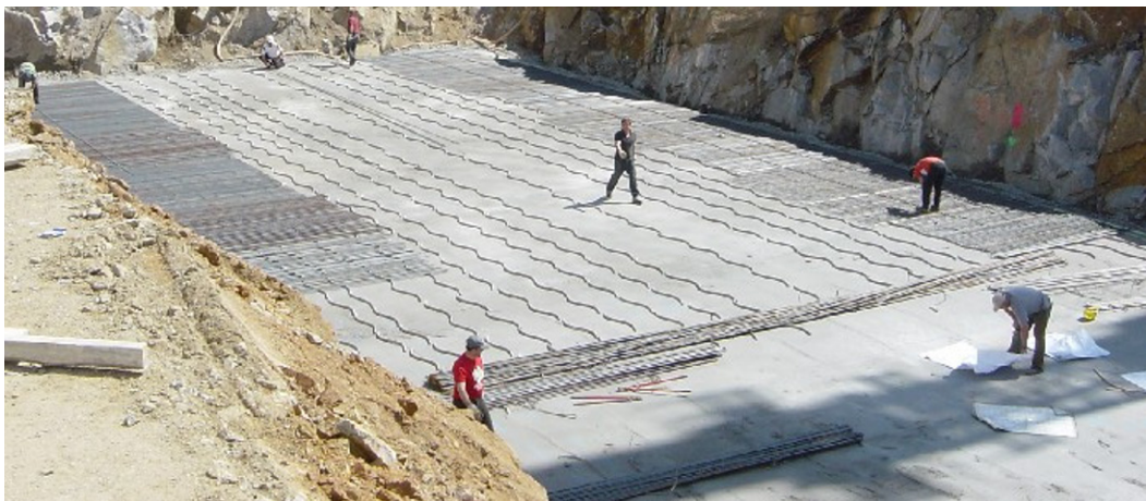
Bild 8.3 Auslegen von Abstandshaltern auf der Sauberkeitsschicht vor Beginn des Bewehrungsaufbaues des Plattengeflechts
