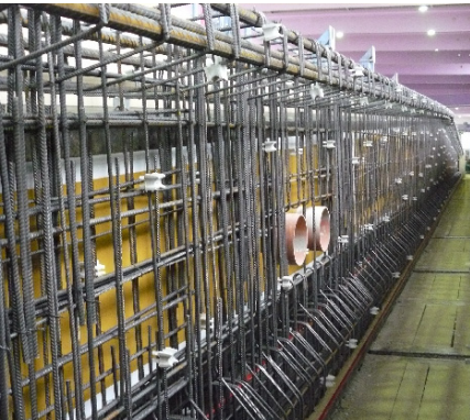
Bild 1.10 Spannbetonbinder mit 38m Länge in der Fertigung (links) und auf der Montage (rechts)
