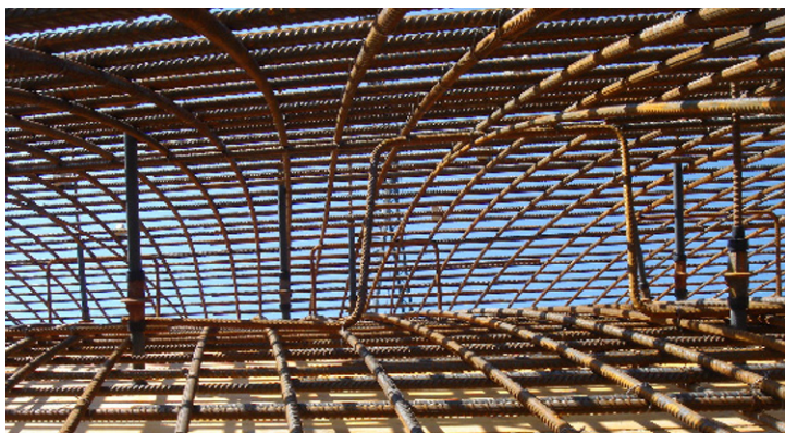
Bild 7.31 Bildausschnitt des im Bild 7.30 geplanten Brückenüberbaus mit der Biegeform 32 plus einer „Zusatzspindel“.
