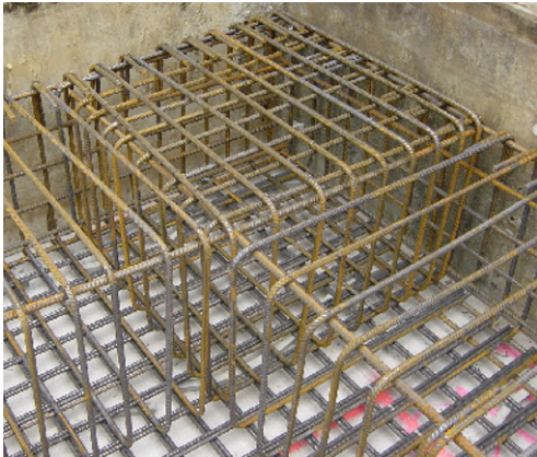
Bild 7.1 Eckenbewehrung einer Bodenplatte
