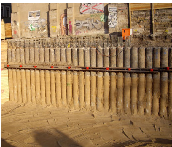
Bild 7.47 Wirkung einer Bohrpfahlwand zur Abfangung eines Gebäudes und einer Baugrube
