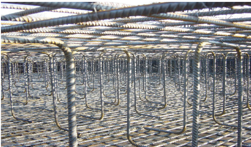
Bild 1.17 Ein ebenes Geflecht in zwei Lagen mit vor Ort gefertigten Matten
