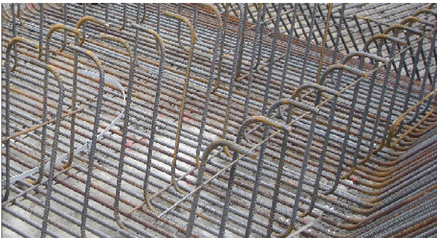
Bild 10.10 Schubbewehrung in einer Bodenplatte (wie in Bild 10.9 gezeigt)
