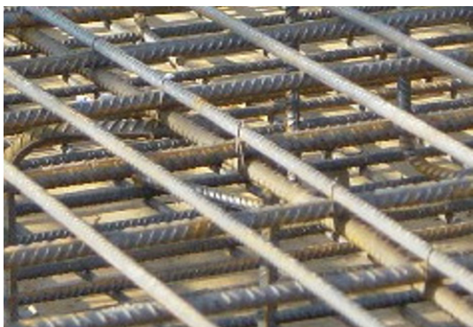
Bild 3.29 Geflechte mit Stabkreuzungen, die aus der Notwendigkeit heraus sowohl mit als auch ohne Maschenknüpfung sind
