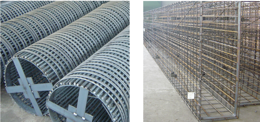
Bild 7.49 Der gefertigte Pfahlkorb von unten links und der Schlitzwandkorb von oben rechts
