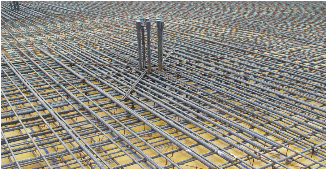
Bild 2.10 Die „Verlegeregeln“ im Bild erkennbar: Alle Stäbe sind linear, planar und orthogonal geordnet einzubauen.
