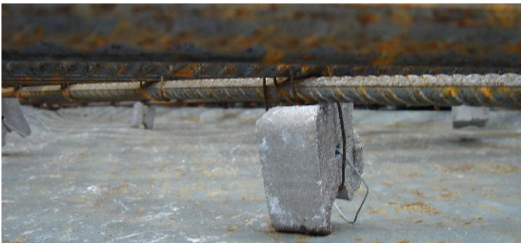
Bild 7.63 Das Stab-Knochen-Prinzip mit einem Montagestab unter der unteren Lage mit wenigen Abstandshaltern
