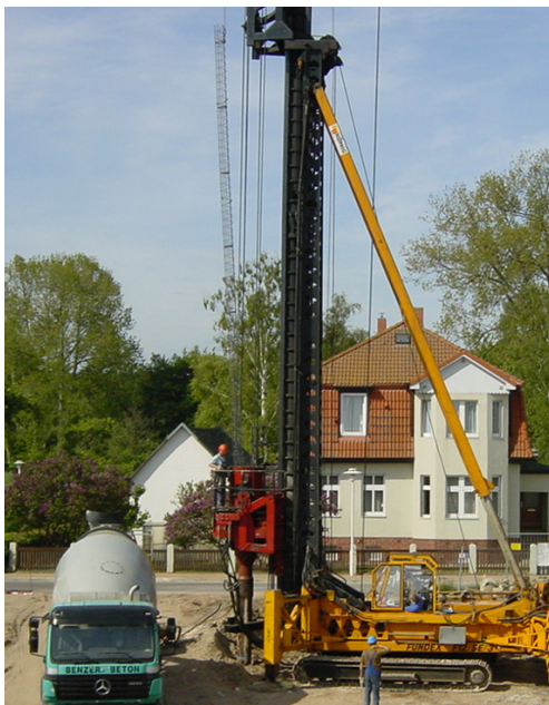
Bild 7.55 Einfahren des Pfahlkorbes
