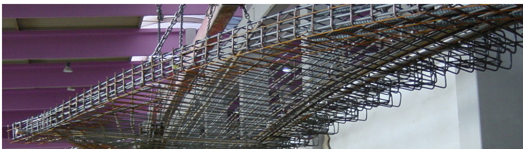
Bild 1.15 Der Bewehrungskorb für einen Tribünenträger des Leipziger Zentralstadions
