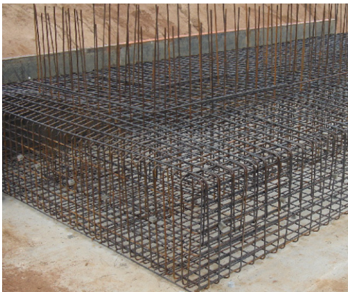
Bild 7.3 Bewehrung eines Stützmauerfußes
