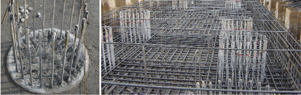
Bild 1.12 Bohrpfahl nach dem Freispitzen (links) und während der Einbindung ins Fundamentgeflecht (rechts)
