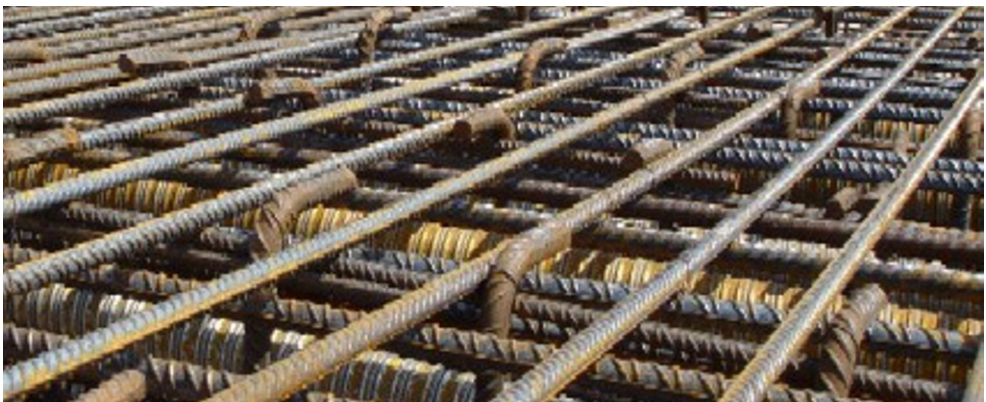
Bild 3.8 Die Rippung zeigt die Kompliziertheit der Maßketteneinhaltung im Stabüber- und -nebeneinander im Geflecht
