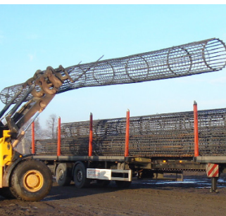
Bild 1.11 Die Bohrpfehleinlage beim Abladen nach dem Antransport, beim Aufnehmen und beim Einfahren ins Bohrrohr
