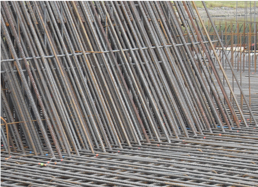
Bild 10.11 Schubbewehrung aus der unteren Lage durch die mittlere in die obere Lage
