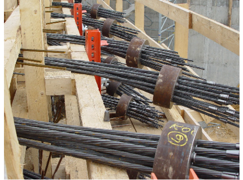
Bild 1.9 Spannstahl vor dem Spannen am Querbalken
