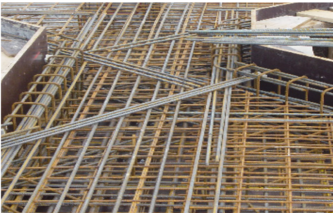
Bild 6.17 Gebogene Matten und Stäbe in einer durch Aussparungen verengten Decke
