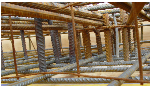
Bild 8.4 Unterstützungen im ungenau konstruierten Plattengeflecht
