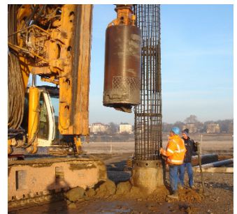
Bild 1.11 Die Bohrpfehleinlage beim Abladen nach dem Antransport, beim Aufnehmen und beim Einfahren ins Bohrrohr
