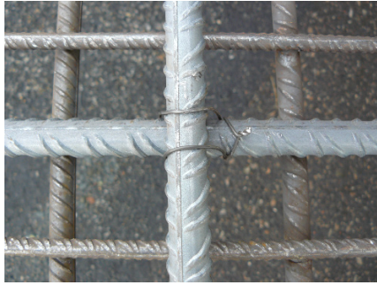
Bild 3.32 „Schlaufe“ bei horizontal belasteten Stäben an vertikal stehenden Stäben im Geflecht
