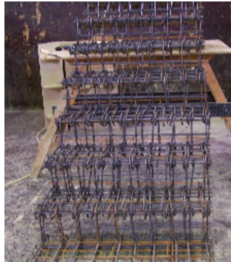
Bild 7.16 Ein einfacher Treppenkorb (links) und ein Treppenkorb mit Stufenausbildung (rechts)
