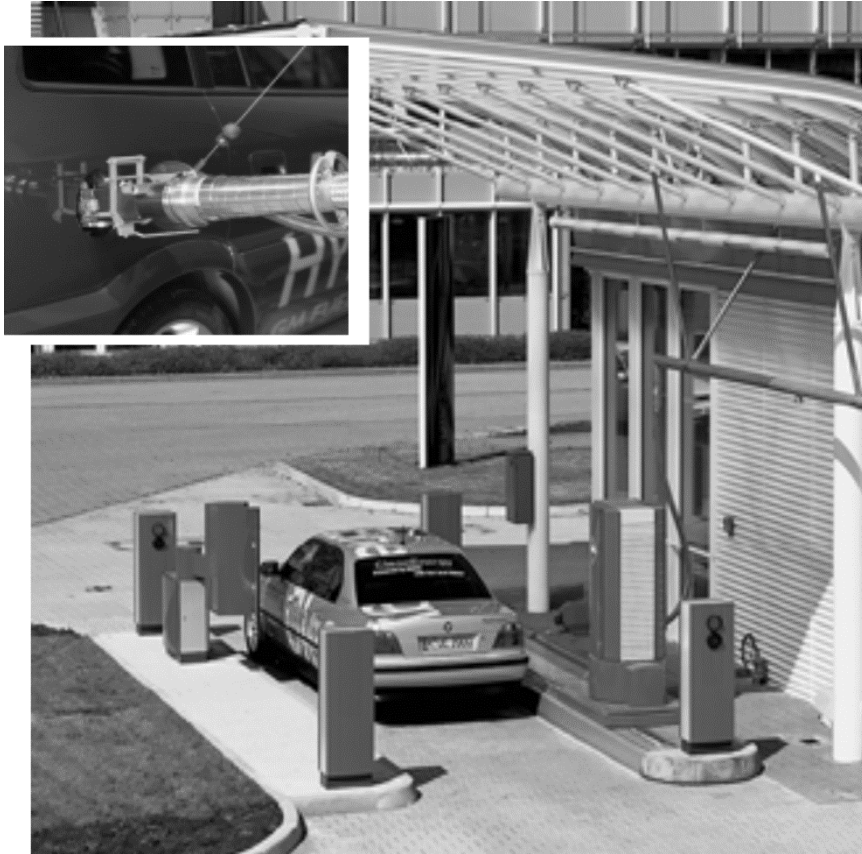
Bild 160 Wasserstofftankstelle für Automobile (Quelle: BMW)
