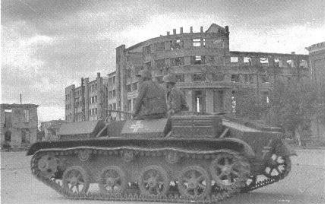
Eine vom T 60 abgeleitete Ausführung im Dienst der Deutschen Wehrmacht. Der Drehturm ist abgenommen, das Sicherungsfahrzeug nur mit einem MG 34 ausgerüstet (BA).
