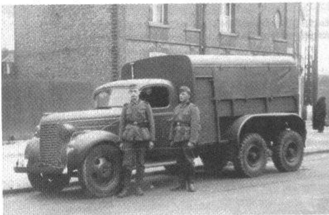
Nachrichten-Kraftwagen auf 1939 Chevrolet-Fahrgestell mit DAF-Aufbau. Ursprünglich leichtes Zugmittel für die Niederländische Armee.
