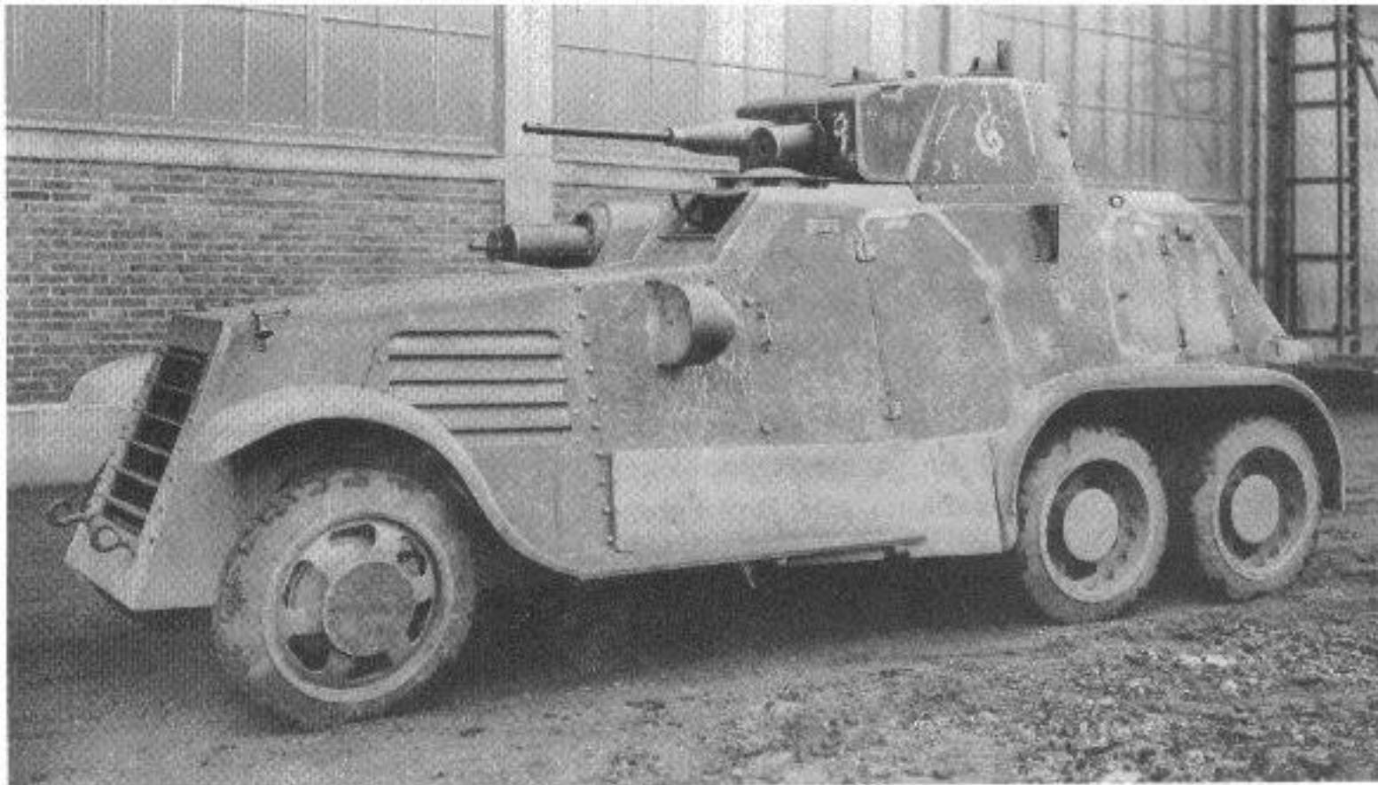
Die Fahrzeuge wurden bei der schwedischen Firma Landsverk mit gepanzerten Aufbauten und Drehtürmen versehen. Sie führten die Bezeichnung L 181. Das Werkfoto zeigt die Originalausführung des L 181.
