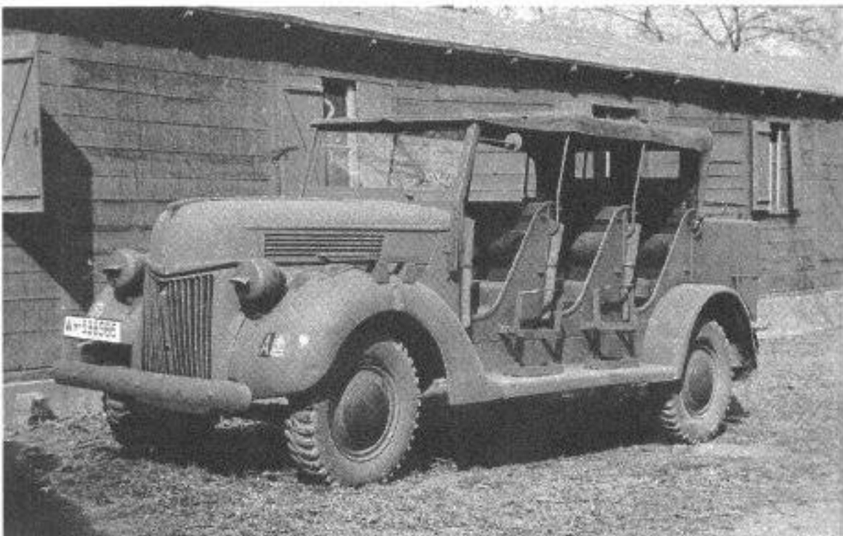
1940 Ford (USA) 1 t Lastkraftwagen, Typ 01Y. Zusammenbau in den Niederlanden. Von der Deutschen Wehrmacht vielseitig eingesetzt.
