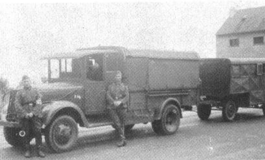
1938 GMC 2,5 t Lastkraftwagen, Typ T 16 B. Fahrgestell montiert von GM Continental. Standard 2,5 t Lastkraftwagen der Belgischen Armee.
