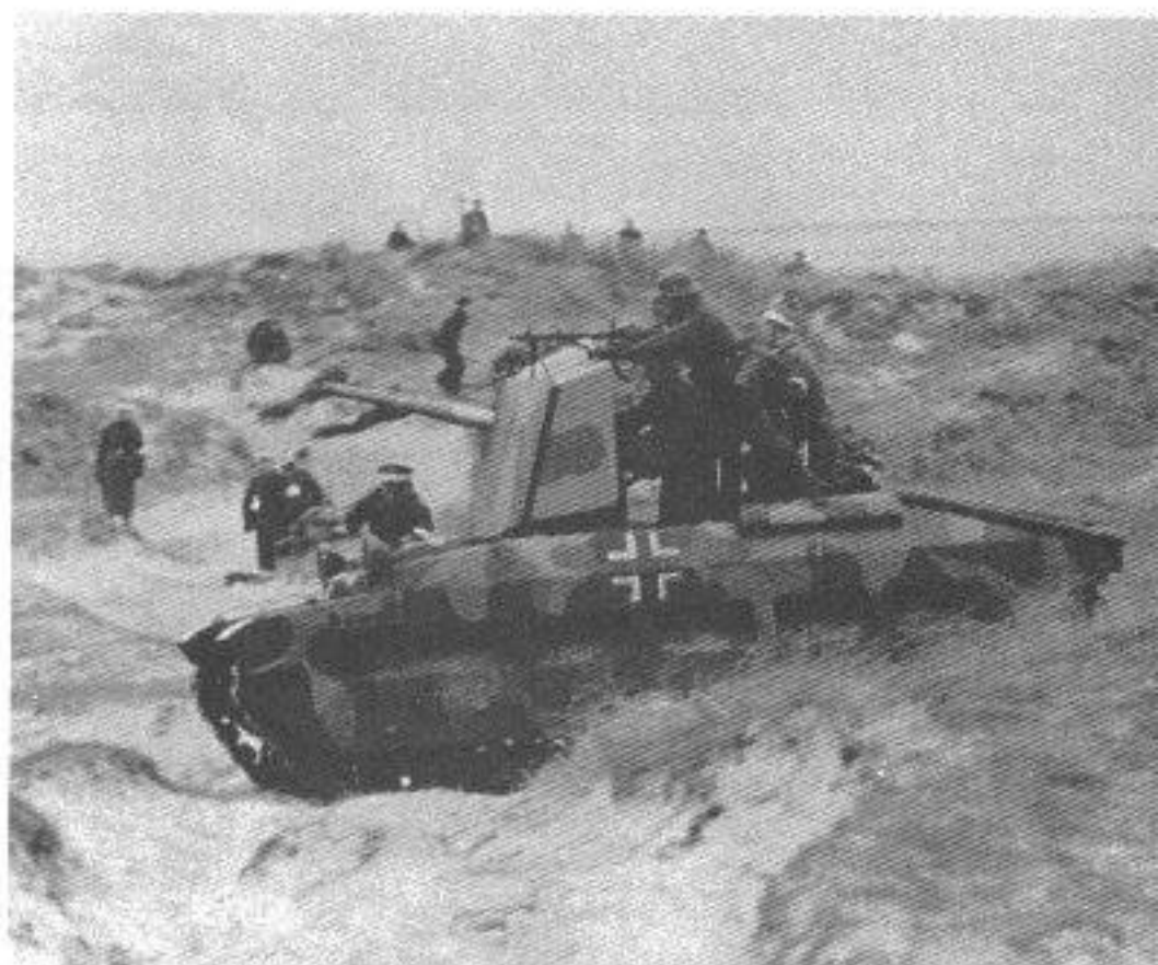
Beide Aufnahmen zeigen einen von der deutschen Truppe umgebauten Infanterie-Kampfpanzer Mk II. Anstelle des Drehturms wurde hinter Schutzschild eine 5-cm-KwK L/42 geführt. Übungen an der Küste Frankreichs.
