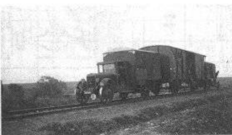
2 russische SIS 5 von der Wehrmacht auf Schienenbetrieb umgestellt.
