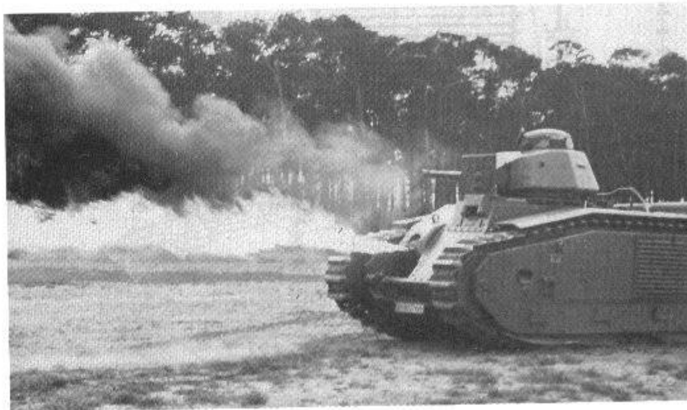
▲ Die Firma Wegmann in Kassel zeichnete für den Einbau der Flammenwerfer verantwortlich. Es wurden Strahlweiten bis zu 45 m erreicht.
