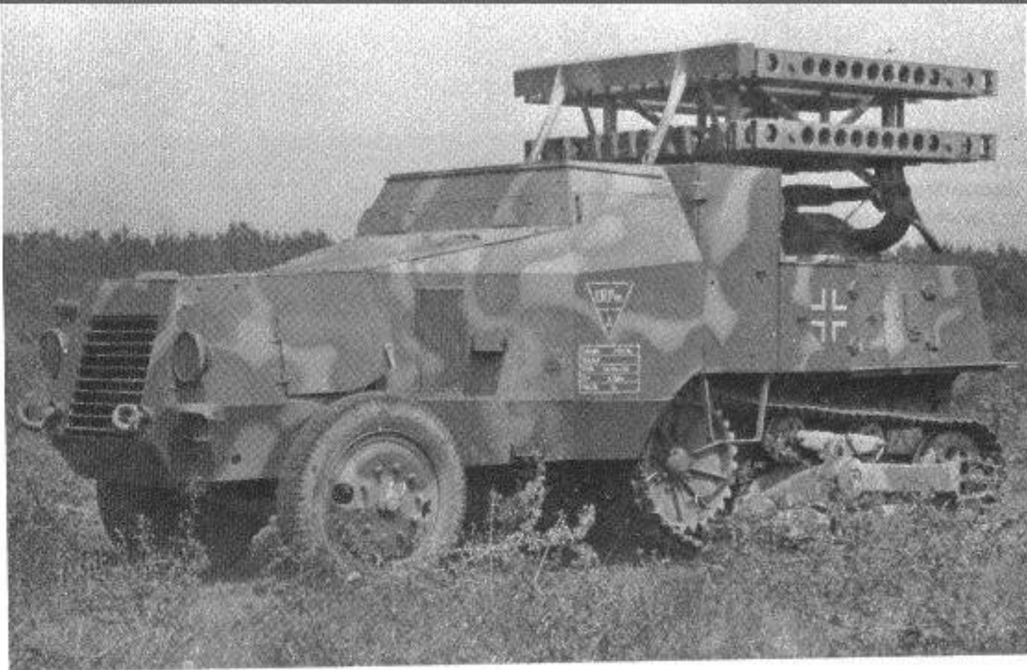
8-cm-Raketen-Vielfachwerfer auf Fahrgestell Somua MCL. Ursprünglich eine Entwicklung der Waffen-SS, wurden sechs dieser Werfer auch für die Schnelle Brigade West gebaut.
