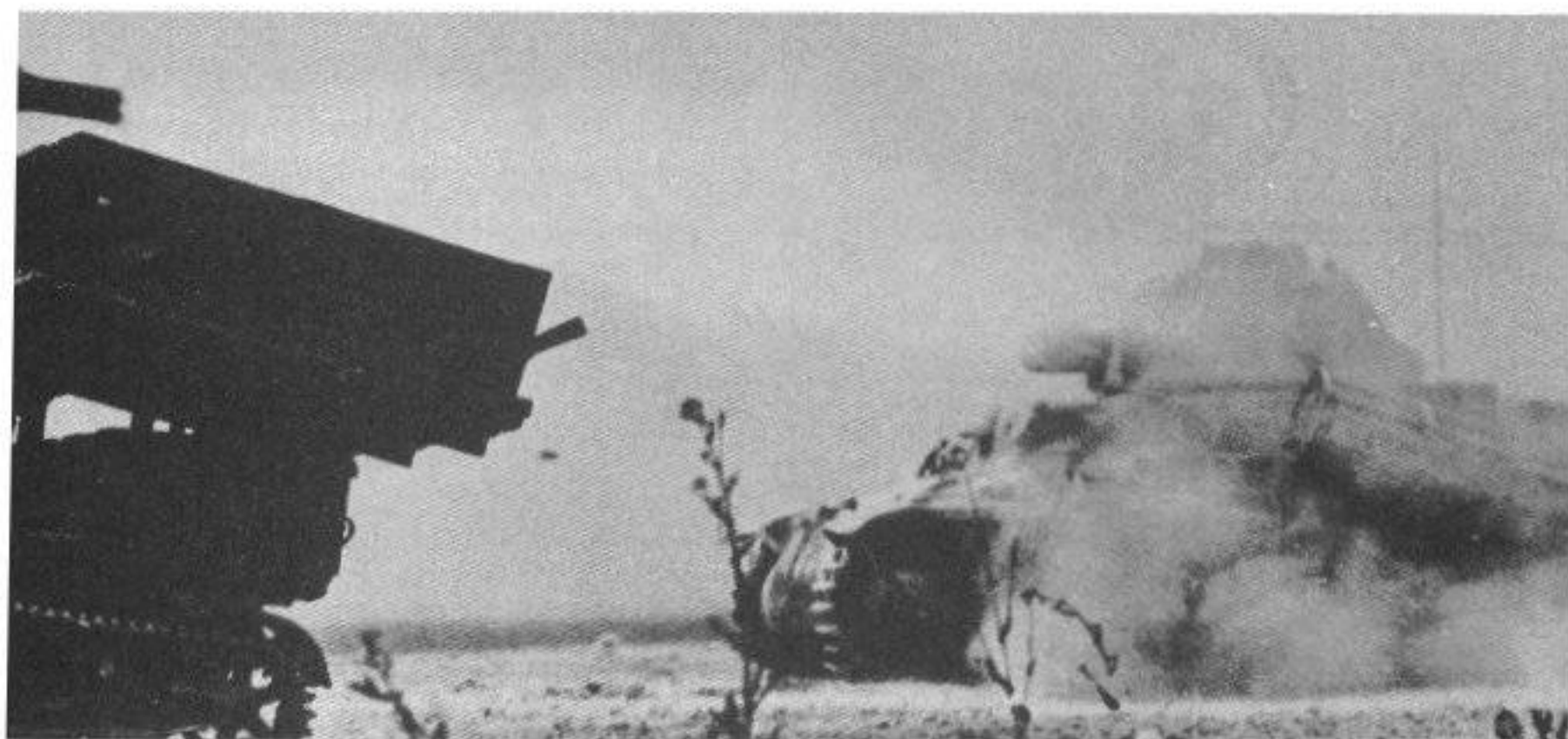
Ein Panzerkampfwagen Hotchkiss 38 H mit seitlich angebrachten Wurffrahmen 28/32 cm. Links im Bild ein Renault UE mit auf der Ladefläche installierten Wurffrahmen.
