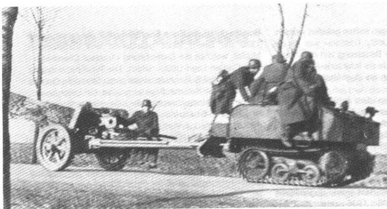
Der zum Teil in Belgien in Lizenz gebaute Vickers »Utility Tractor« zog bei der Deutschen Wehrmacht u. a. die 5-cm- und 7,5-cm-Pak.
