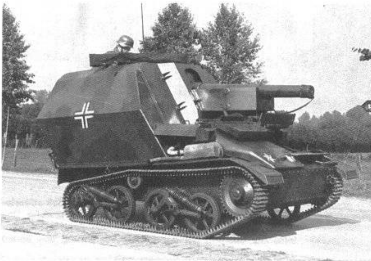
Eine verbesserte Ausführung des Geschützwagen Mk VI hatte eine geänderte Frontalpanzerung mit zusätzlichem Panzerschutz für die Rücklaufanordnung des Geschützes. Das Fla-MG ist staubsicher verpackt.
