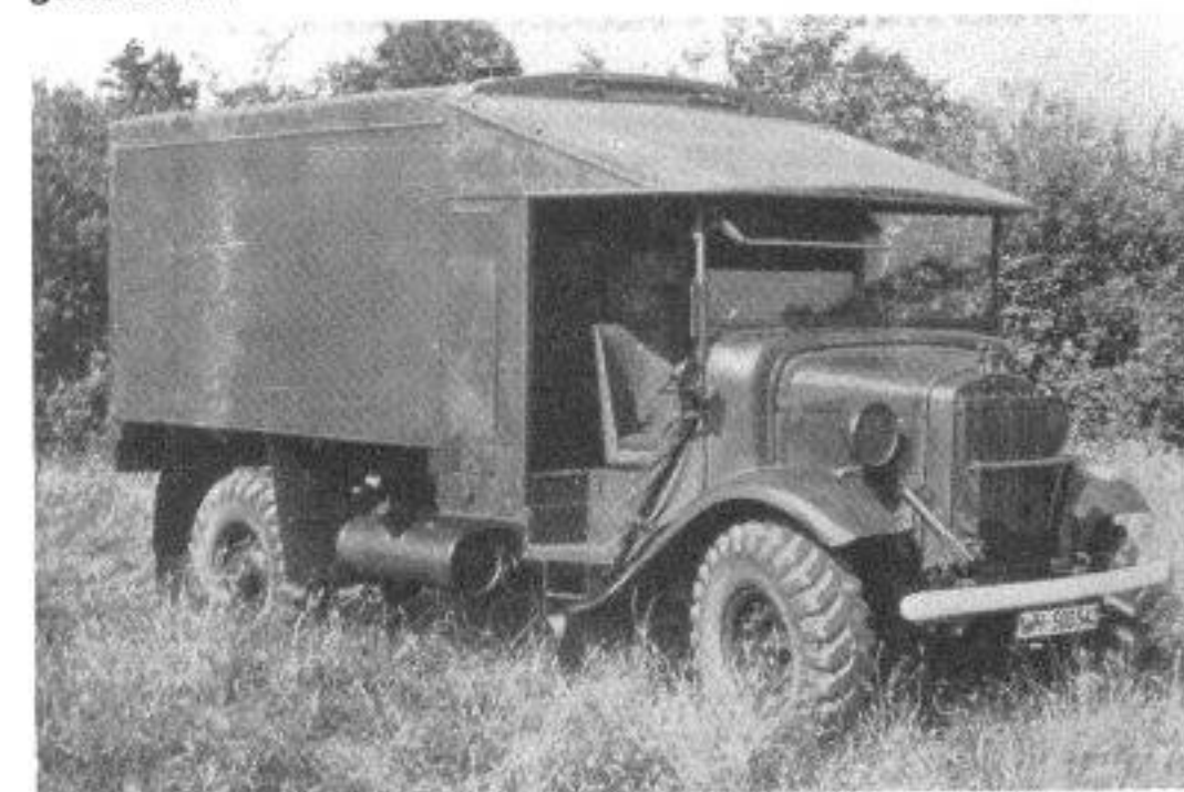
Schwerer Krankenkraftwagen, Morris-Commercial CS 11/30 F. 24 Stück als Troßlastkraftwagen bei der »Schnellen Brigade West«.
