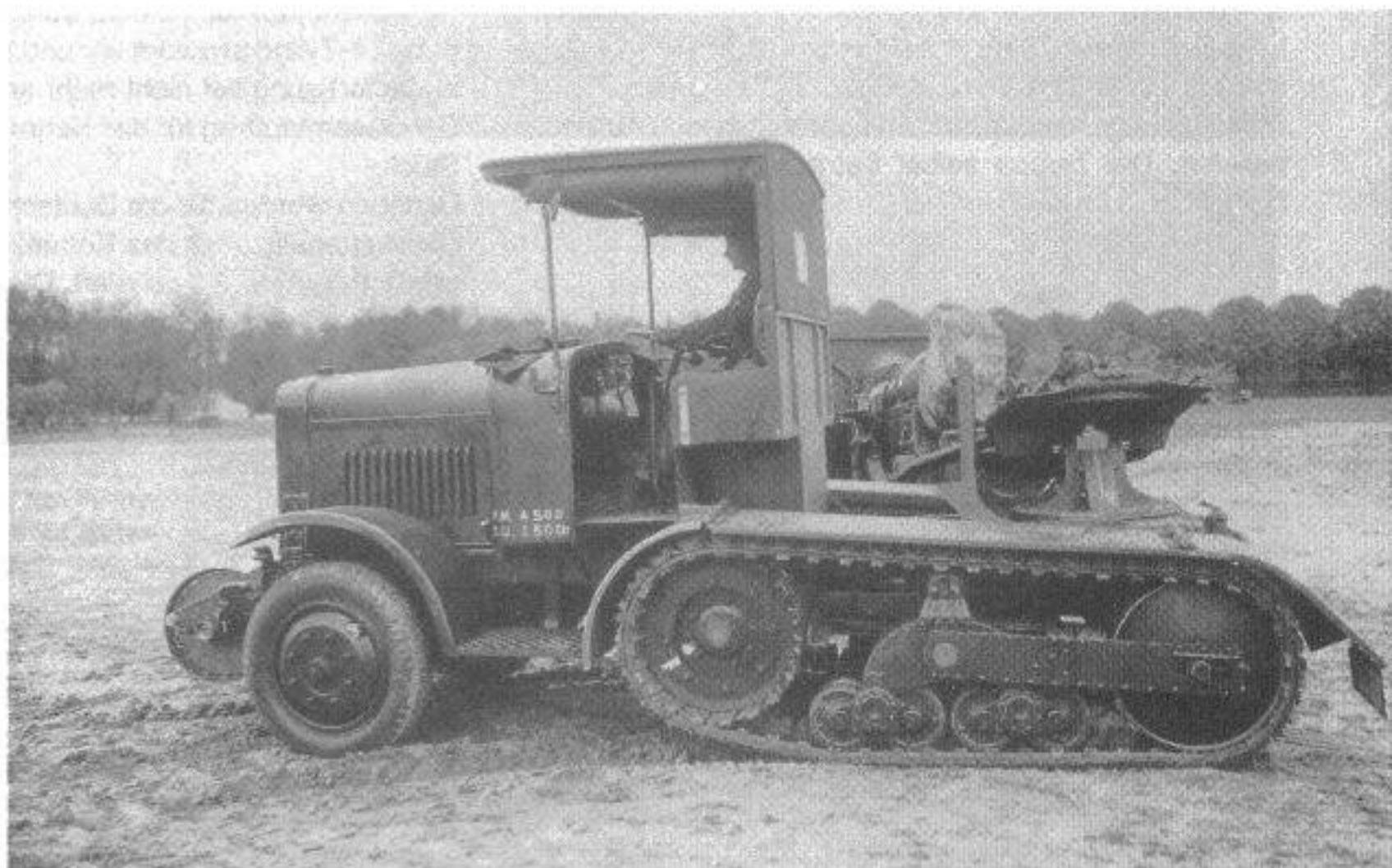
Somua MCG 4, eines der ersten Somua Halbkettenfahrzeuge. Hier in Sattelschlepper-Ausführung als Zugmittel für schwere Geschütze.
