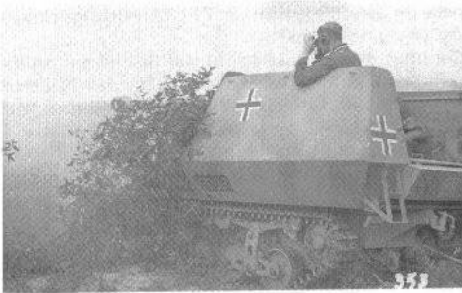
Rückansicht der Selbstfahrlafette für die 7,5-cm-Pak 40 zeigt den Einstieg zum Kampfraum.
