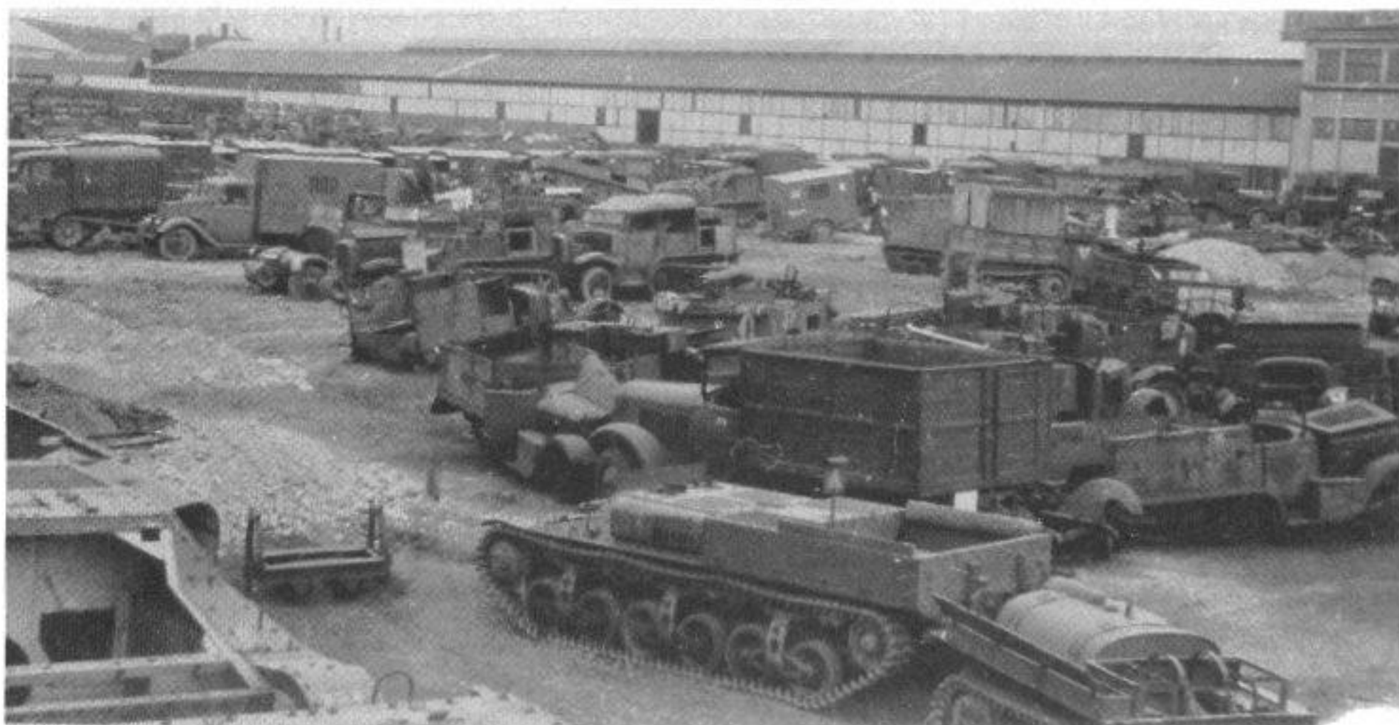
Als Ersatz für den Renault UE erschien 1937 das Gefechtsfeld-Versorgungsfahrzeug Lorraine-S 37. Das Fahrzeug (Bild unterer Rand) war teilweise mit einem Vollketten-Kraftstoffanhänger zum Auftanken von Panzerfahrzeugen auf dem Gefechtsfeld ausgerüstet.
